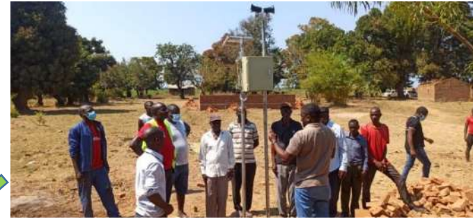
(3.) Alarm Unit (AU)
